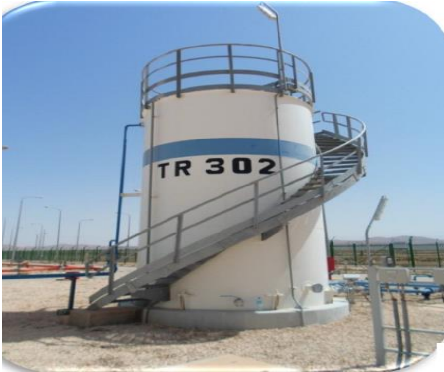
Fig. I.10 : Bac de stockage eau service.
