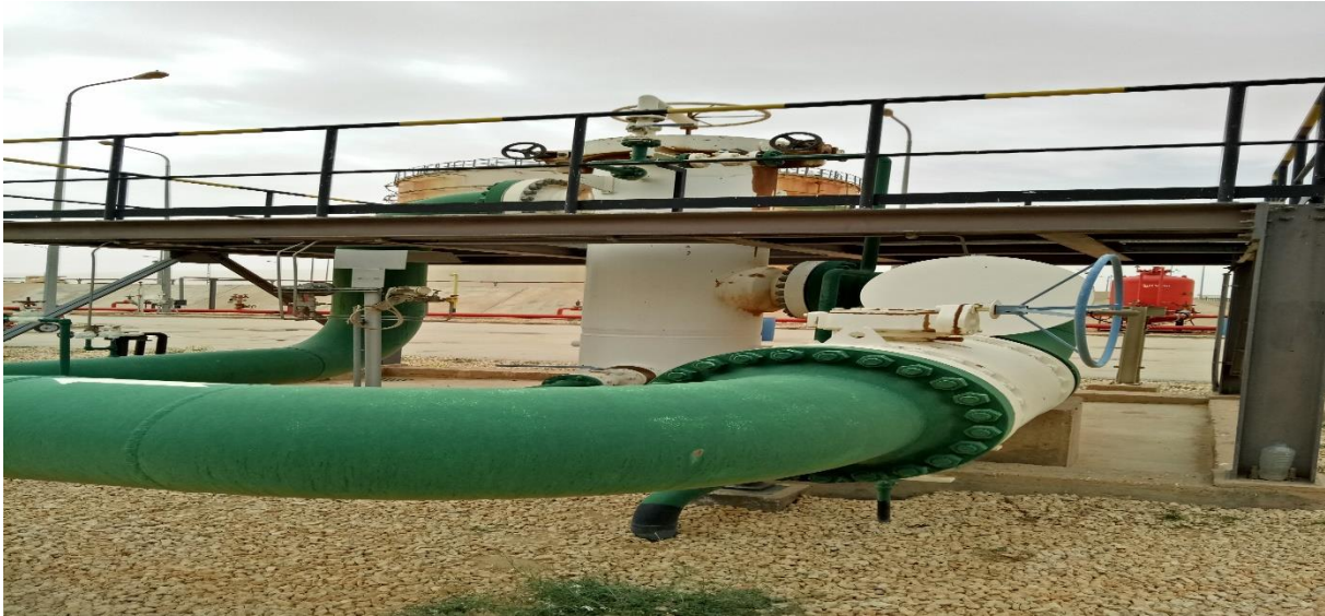
Fig. I.3 : Filtre du type à panier.
