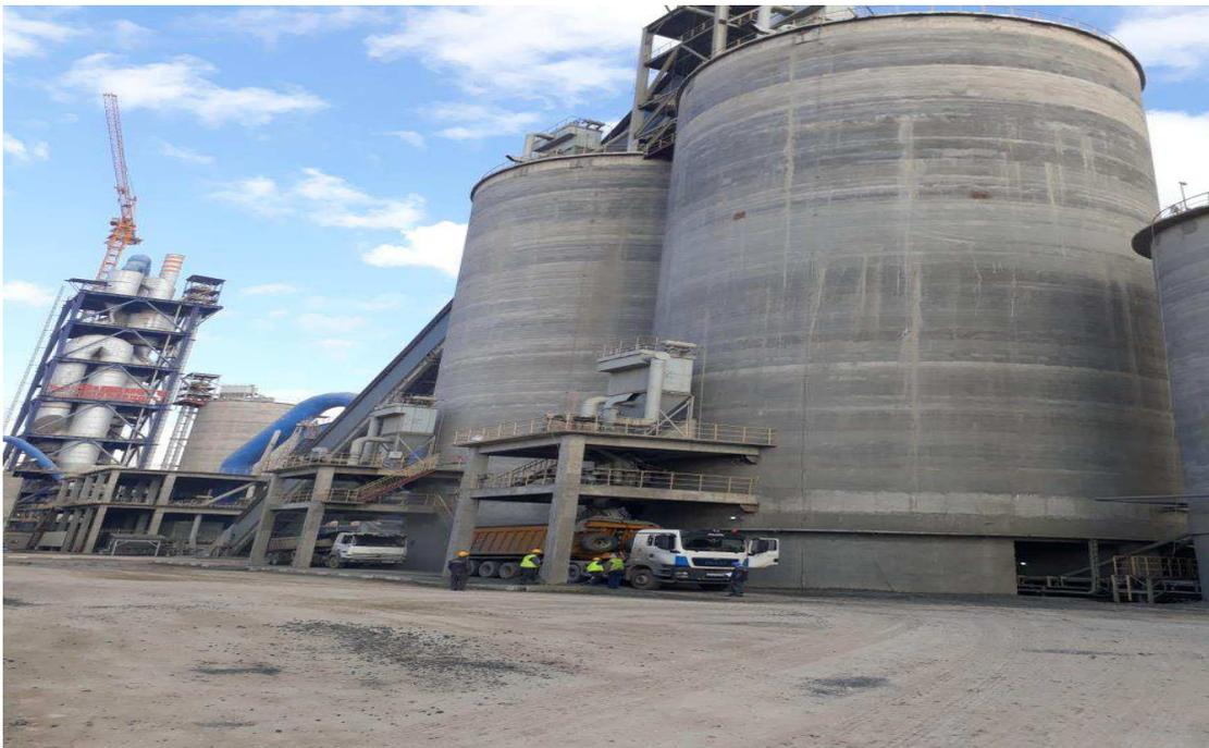
**Figure I.11 : Silo stockage de clinker.**
