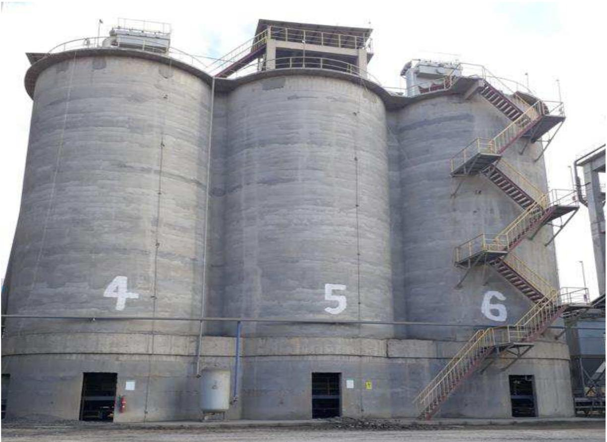
**Figure I.13 : Silo stockage de ciment.**
