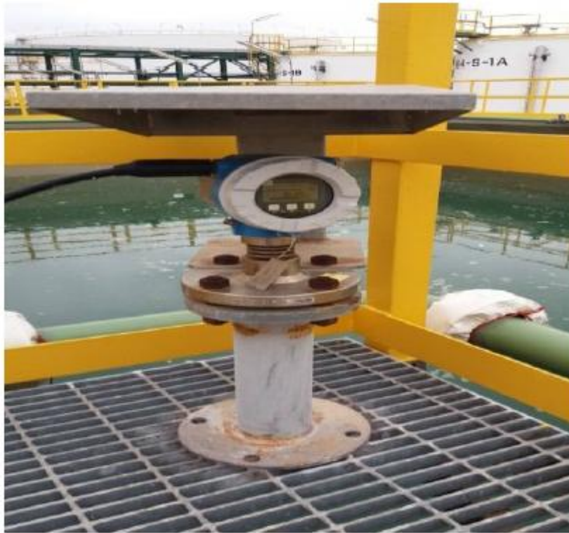
FIGURE I.19 — capteur de niveau (radar).
