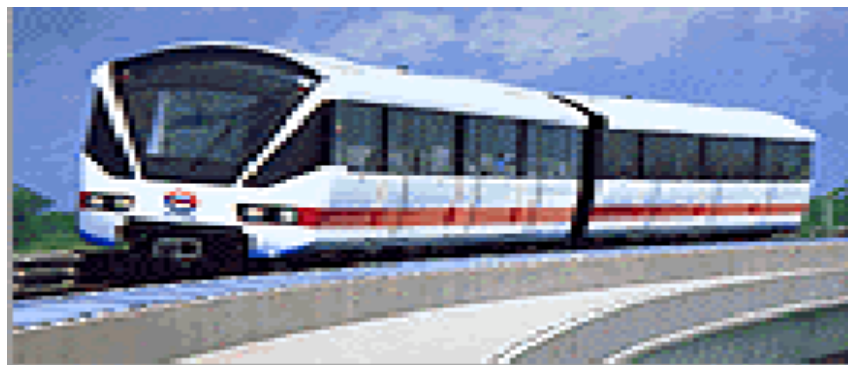
Figure II.26 : Métro de Kuala Lumpur à moteur linéaire
