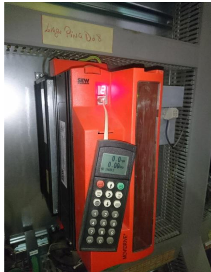
Figure.I.19. Schéma d'un variateur de vitesse ( MDX61B0030-5A3-4-OT ).
