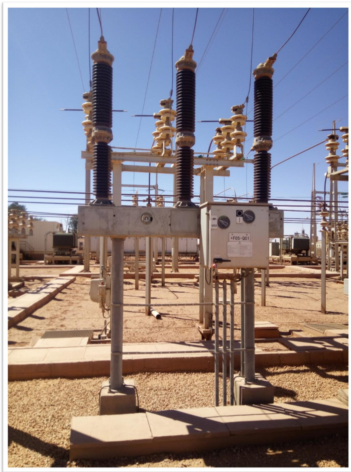
Figure I.5 : Disjoncteur à gaz SF6 (SONATRACH SH DP IN AMENAS).
