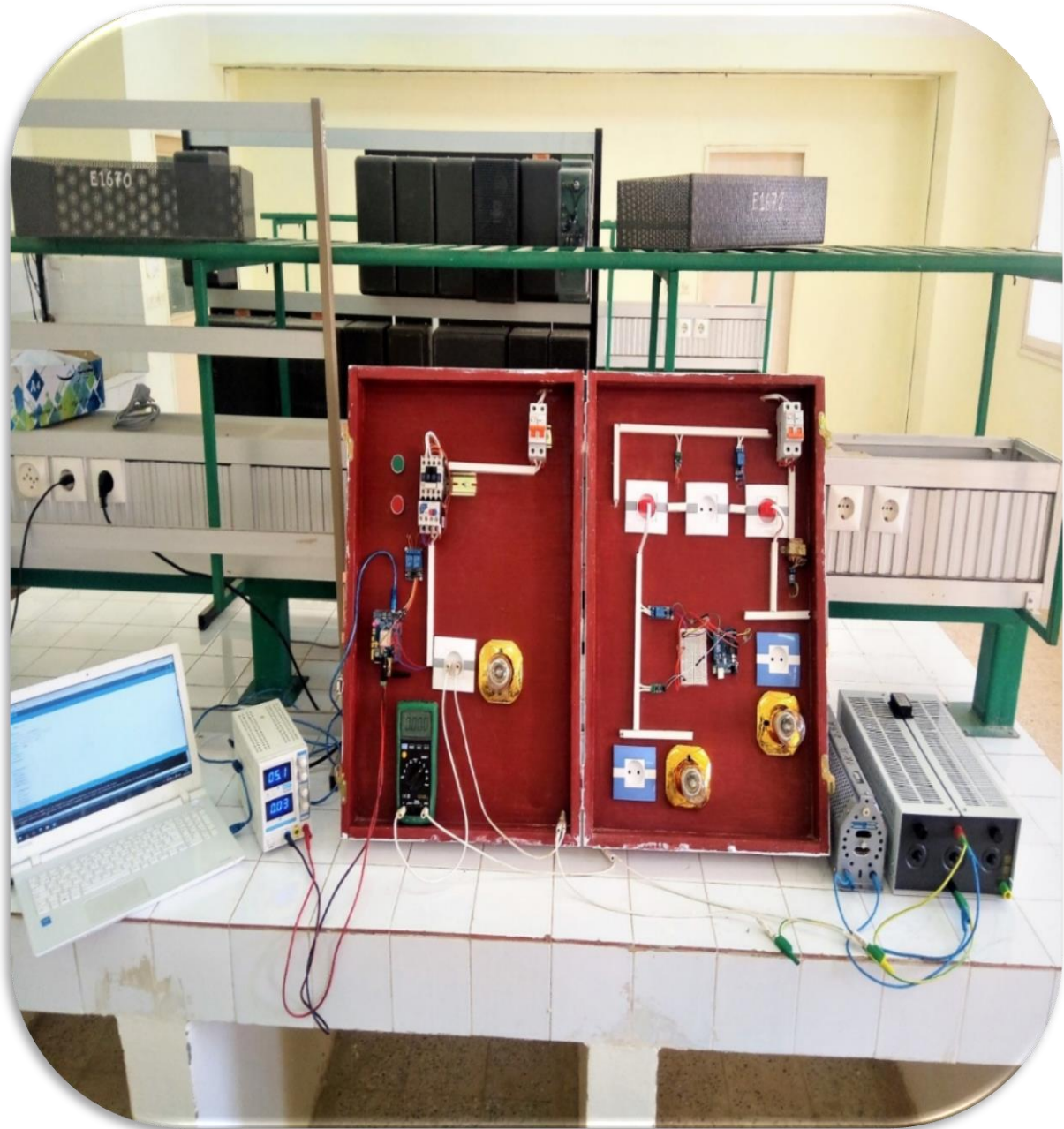
Figure III.16 : Armoire générale dédiée à la sélectivité des protections et la commande à distance à base de l'Arduino et de la carte GSM.
