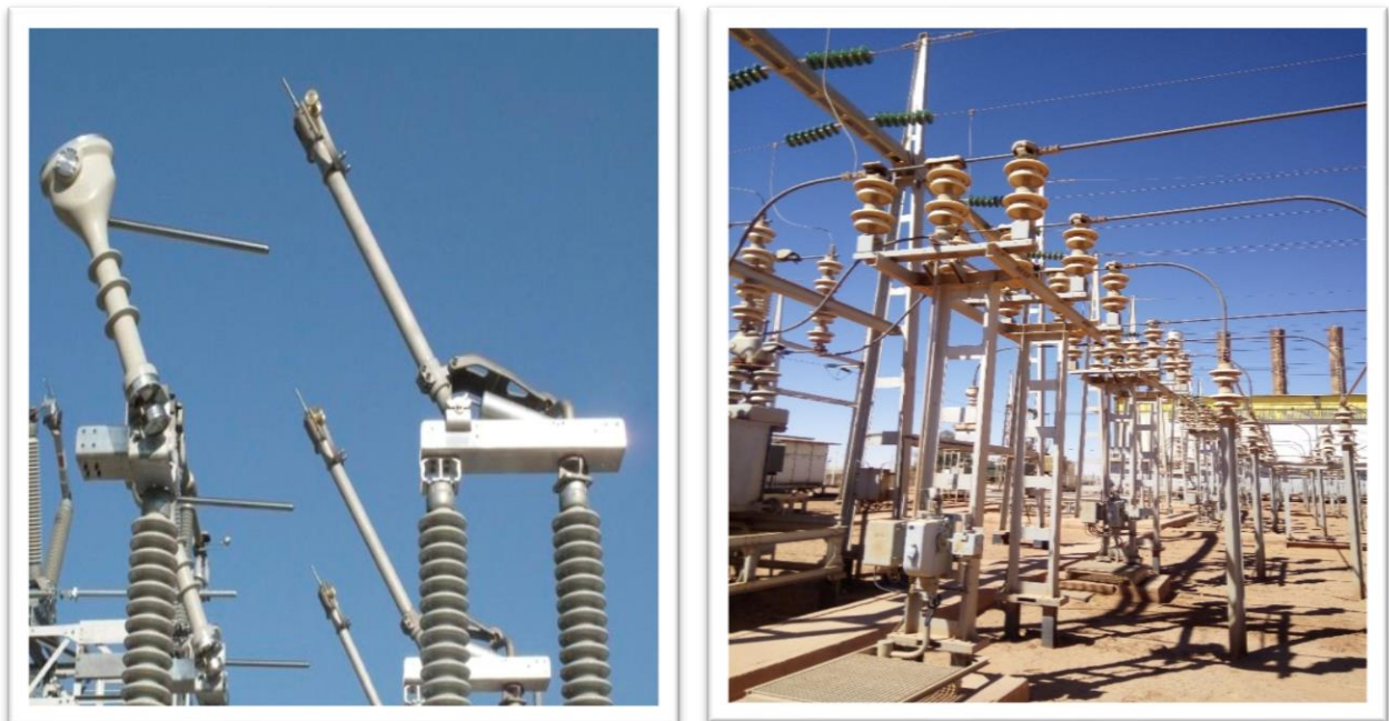
Figure I.9: Sectionneurs MT et HT ( SONATRACH SH DP IN AMENAS ).
