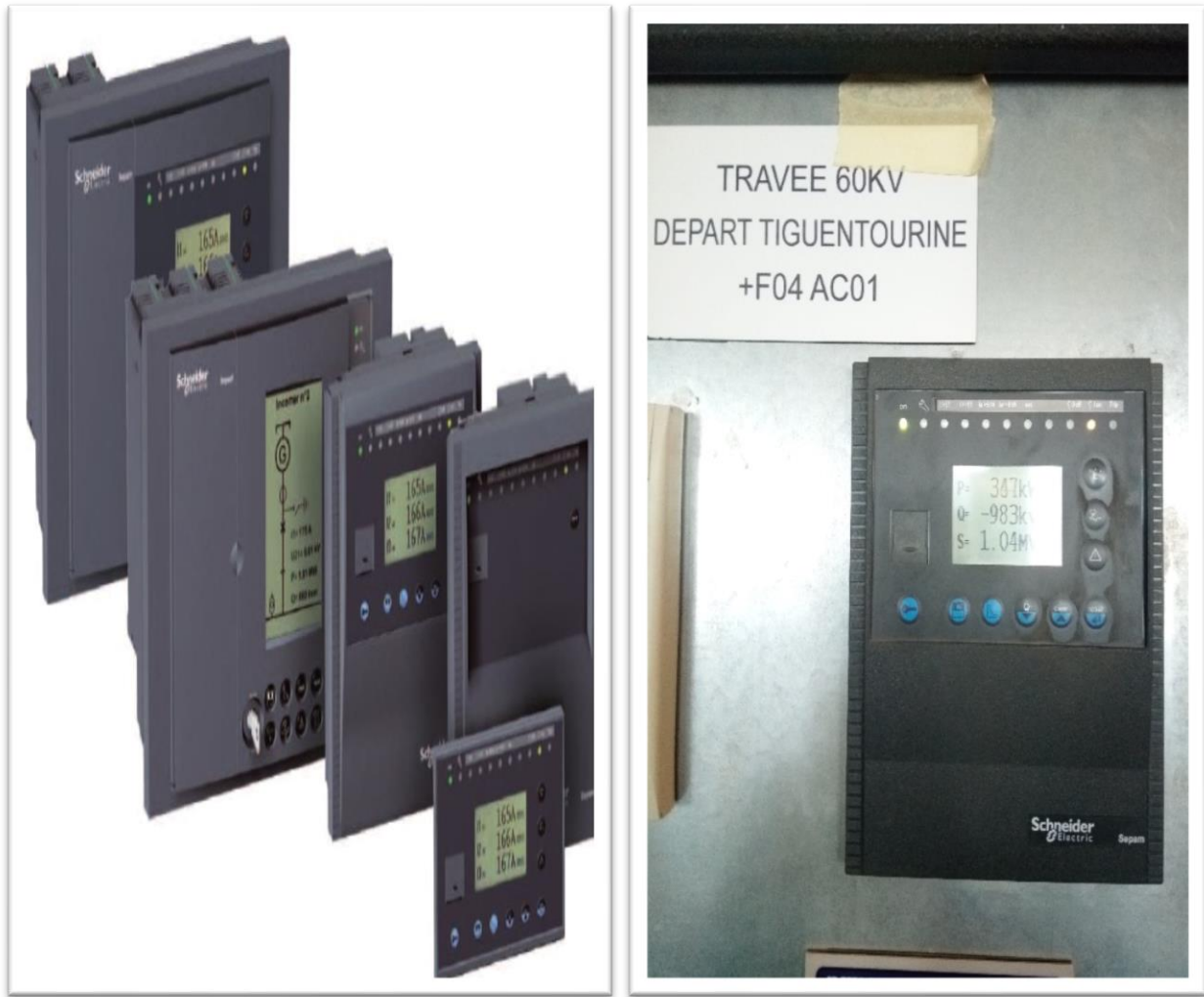
Figure I.12 Relais numériques 'Sepam' (SONATRACH SH DP IN AMENAS).
