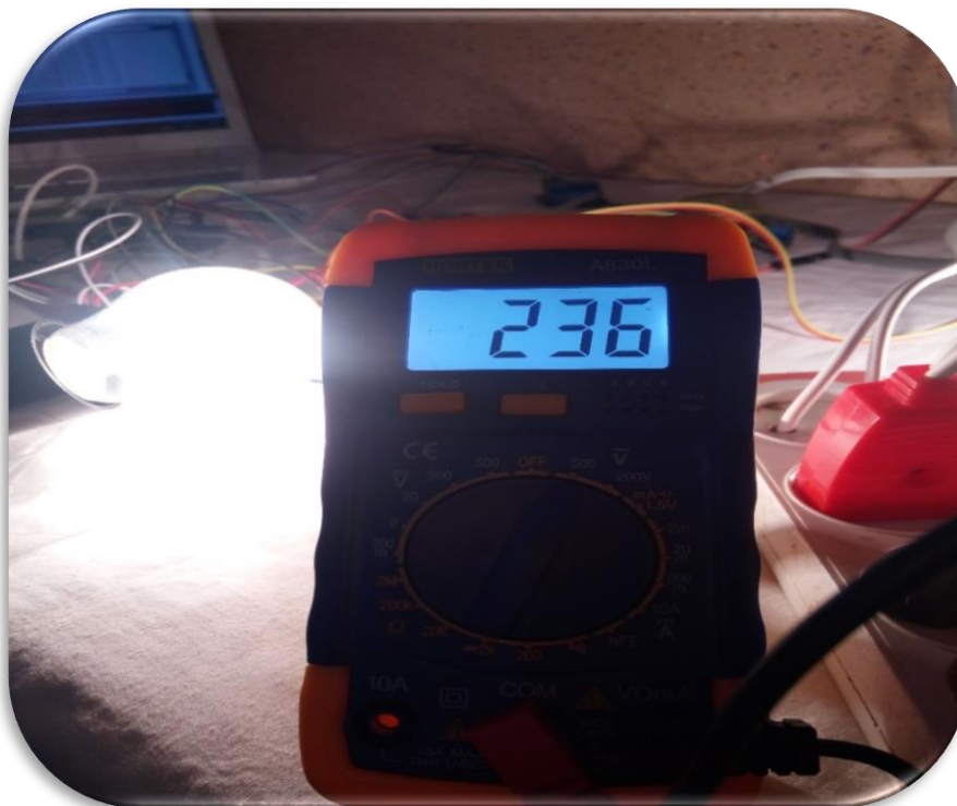
Figure III.3 : Vérification de la tension mesurée par voltmètre.
