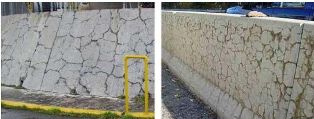
Figure 2.19 : L'image de gauche est une structure auxiliaire au barrage Belesar en Espagne, et l'image de droite montre le modèle de fissures caractéristique affectant une barrière de sécurité sur une autoroute aux États-Unis. [13]
