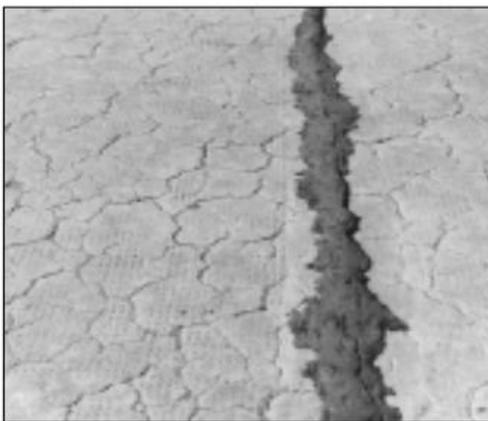
Figure 2.15 Fissuration en faïençage et éjection du matériau de remplissage de joints causée par l'expansion du béton soumis à la réaction [16]
