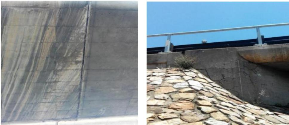
Figure 2.18 : Endommagement de la culé par apparition de fissuration  $>25$  mm d'ouvertures sur le pont Golden à Jobourg, Sud Afrique, et l'image de droite montre des fissurations au joints de deux voussoirs. [13]
