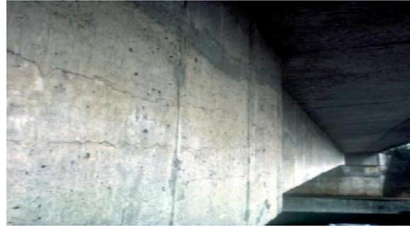
fissuration orientée horizontalement sur une poutre précontrainte
