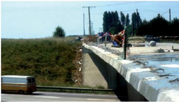
déformation excessive (flèche d'une travée de pont-dalle en béton armé)
