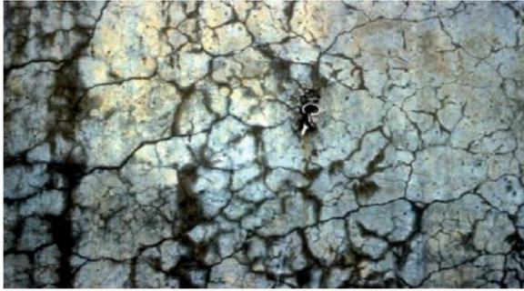
maillage de fissures sur un mur en aile
