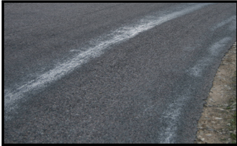
Figure II.24 : glaçage ou L'indentation
