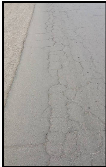
Figure III.37 : Faiçençage de la bande du Roulement
