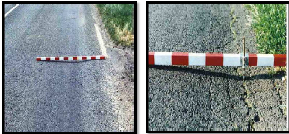
Figure II.15 : Affaissements de rives. (Damien et al, 2012)
