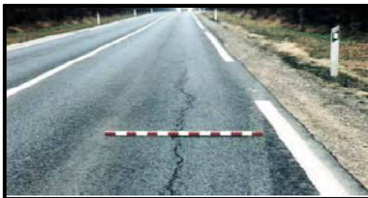
Figure II.20: Fissure longitudinale.
