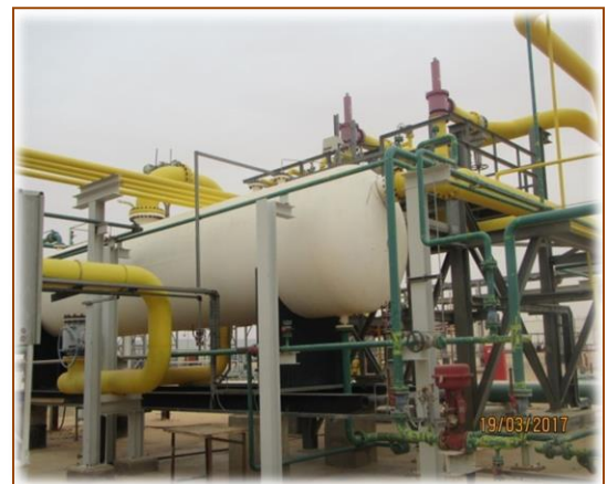
Figure I.5 : Séparateur HP ( High Pressure )
