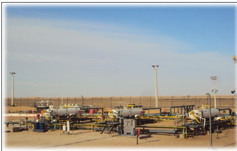
Figure III.16. Les trois séparateurs du centre Old Zotti (Brown Zotti)
