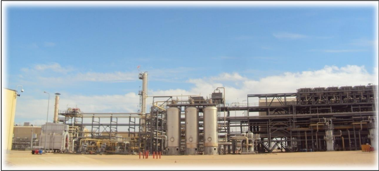
Figure III.14. Centre de compression et de reinjection de gaz Zotti champs GEA
