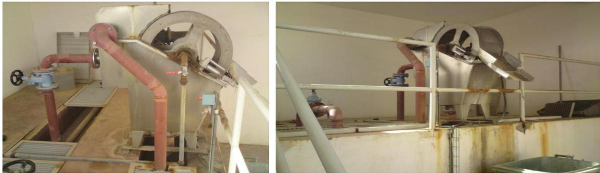
**Figure .IV.2.** Prétraitement (dégraissage, dégrillage, dessablage) de la STEP d'EL GASSI.
