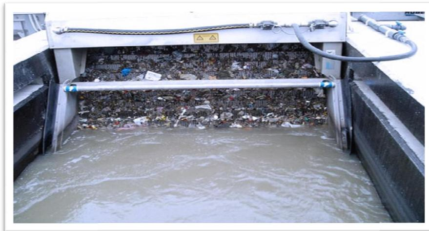
**Figure II.1.**Photo représente un dégrillage [17].
