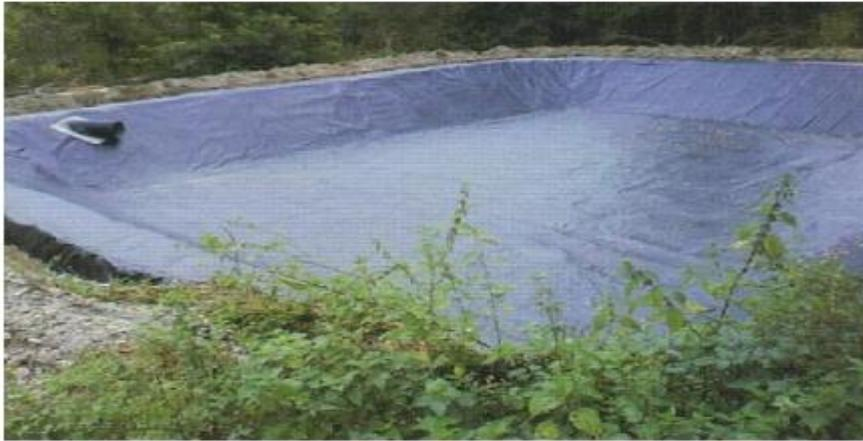
**Figure IV. 31.** Bassin tombe avec l'installation de géomembrane en polyéthylène
