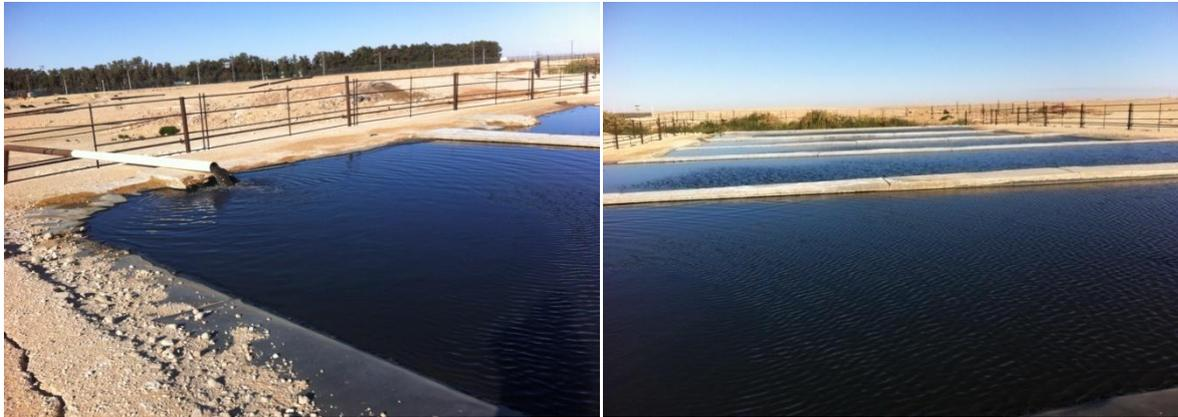
**Figure IV.12.A.** Traitement biologique (lagunage) de la step d'EL GASSI.
