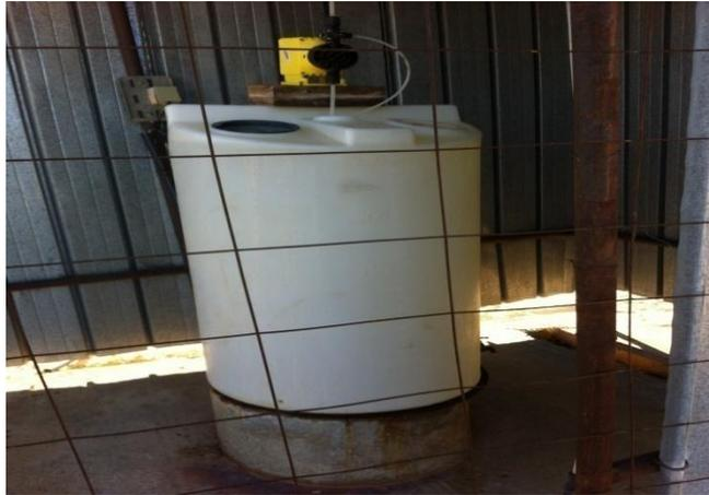
**Figure IV.10.** Bassin injection de chlore.
