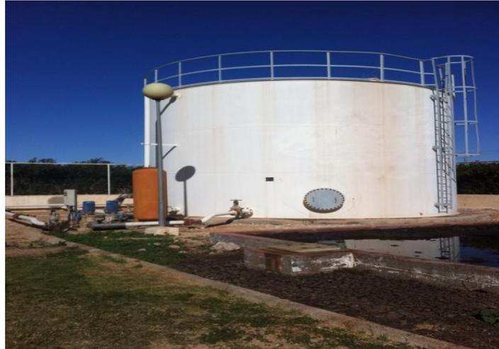
**Figure IV.6.** Bac de stockage de l'eau traitée.
