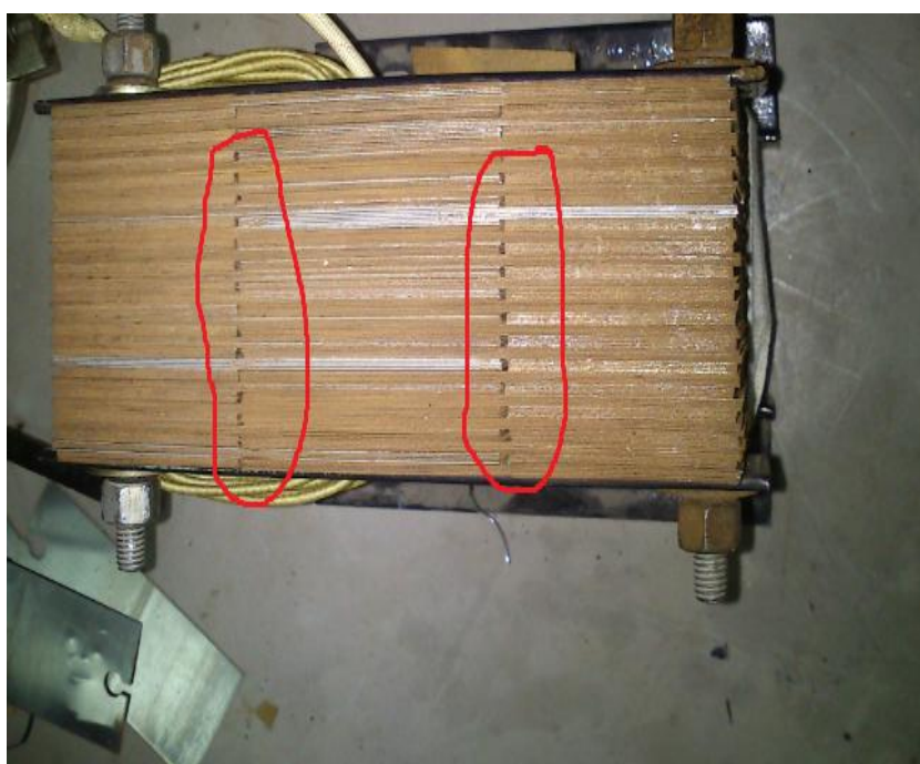
Fig.III.7. Serrage des tôles
