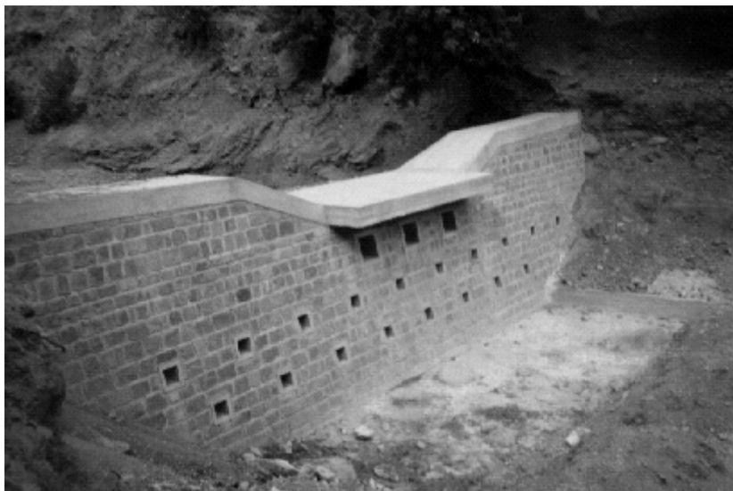
**Figure 10 :** Seuil d'amortissement des écoulements d'un affluent de l'Ourika
