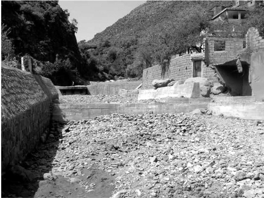
**Figure 11** : Seuils d’amortissement de l’affluent Tighzirt comblés par les dépôts
