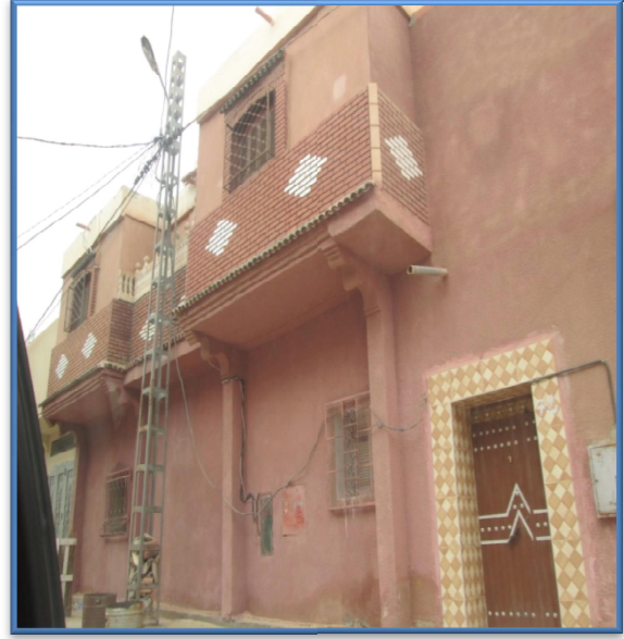
صورة رقم(40):بناية لم تحترم إرتفاق الكهرباء
