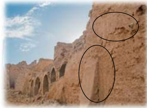
صورة رقم 56: توضح ملاط الطيني في الجدار. المصدر: من التقاط الطالبة 2018
