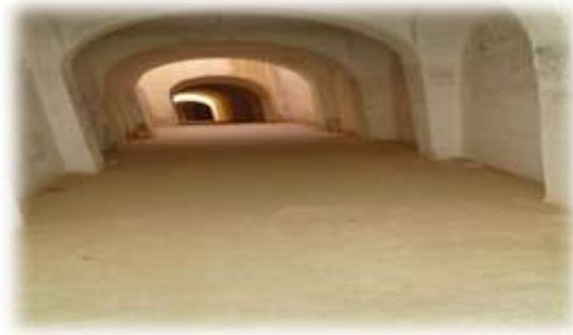
الصورة رقم 26: توضح مسلك فرعي (ممر ثانوي) للقصر. المصدر: من إلتقاط الطالبة 2018
