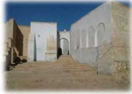
الصورة رقم 64: توضح زخرفة ولون وتلبيس الواجهة القصر.
