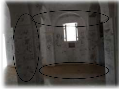
الصورة رقم 55: توضح الجبس التقليدي في الأعمدة والجدران والقبة. المصدر: من التقاط الطالبة 2018
