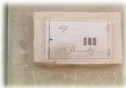
الصورة رقم 108: توضح العداد الخاص للغاز (كنتور). المصدر: من التقاط الطالبة 2018
