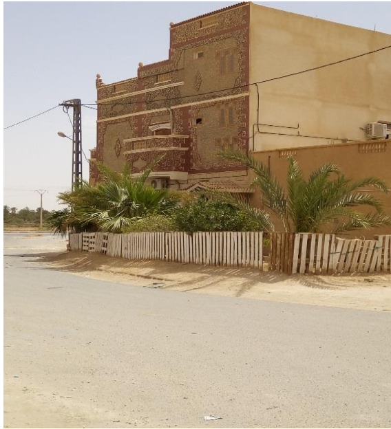
صورة 2 مبنى جيد
