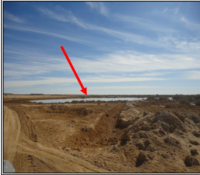
صورة رقم (16) : توضح صعود المياه بالمناطق المنخفضة
