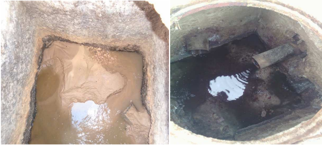
صورة رقم (12) : تدهور شبكة الصرف الصحي وسط مدينة تقرت
