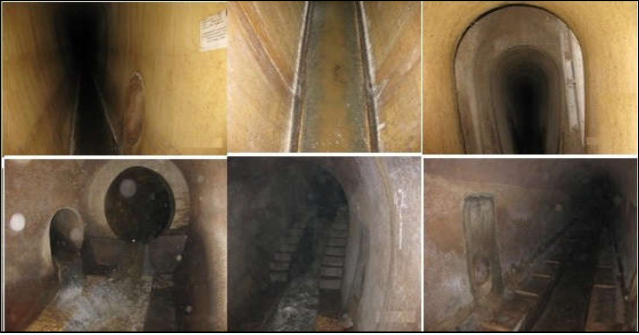
الصورة رقم: 04 تمثل نفق لصرف الصحي
