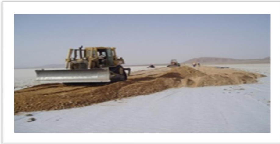
Photo. IX.3 : Mise en place de la 1 ère couche du remblai
