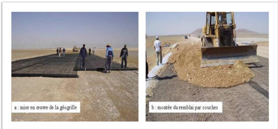
Photo. VIII .3 : Mise en place du géogrid
