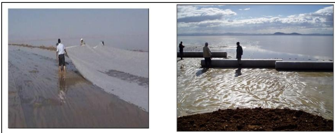
Photo. IX. 2 : Pose des Géotextiles de séparation
