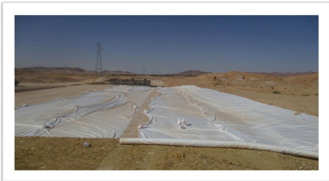
Photo .VIII. 06 : Mise en place du géotextile (AS25)
