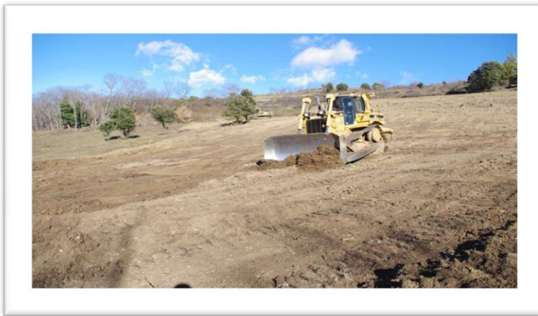
Photo. IX.. 1 : décapage de la terre végétale
