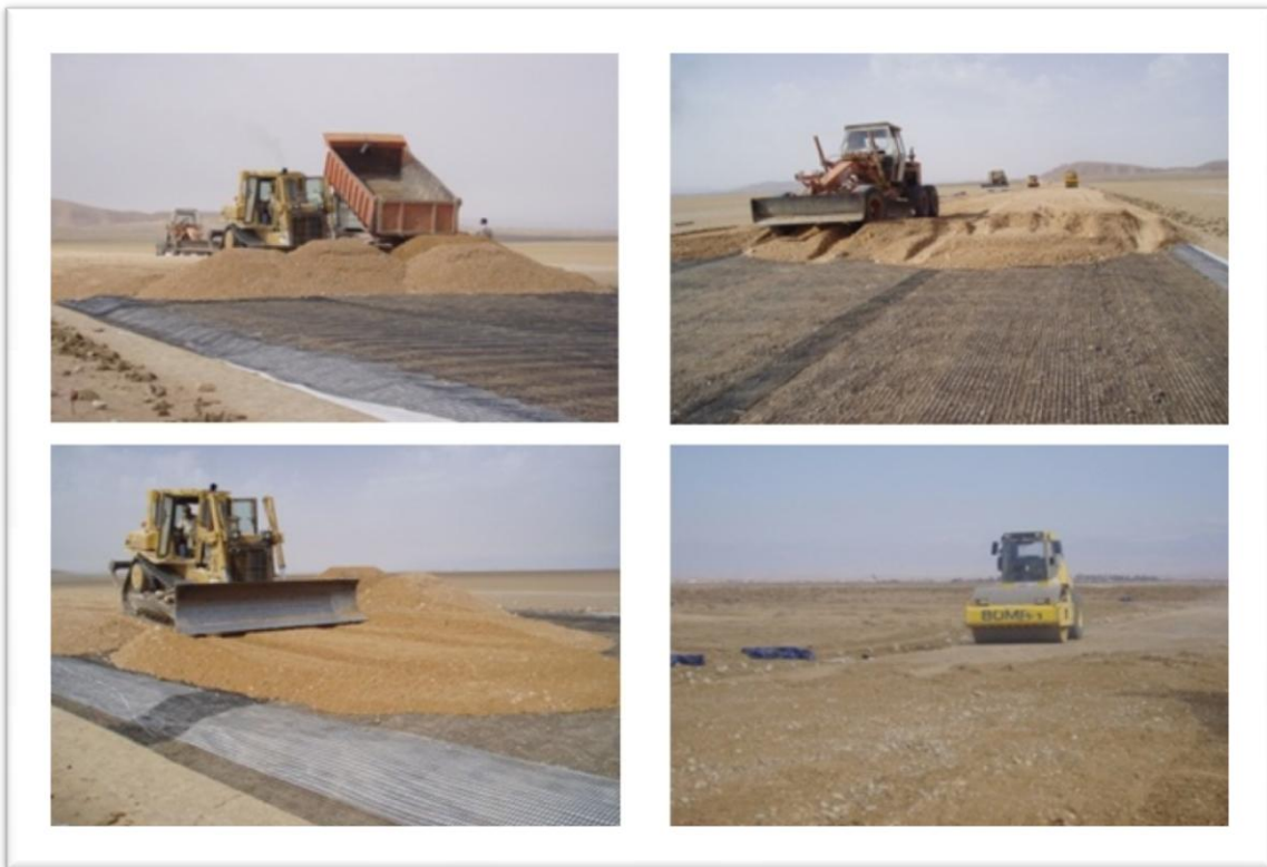
Photo. IX. 5 : pose des couches de remblai sur la géogrille et compactage
