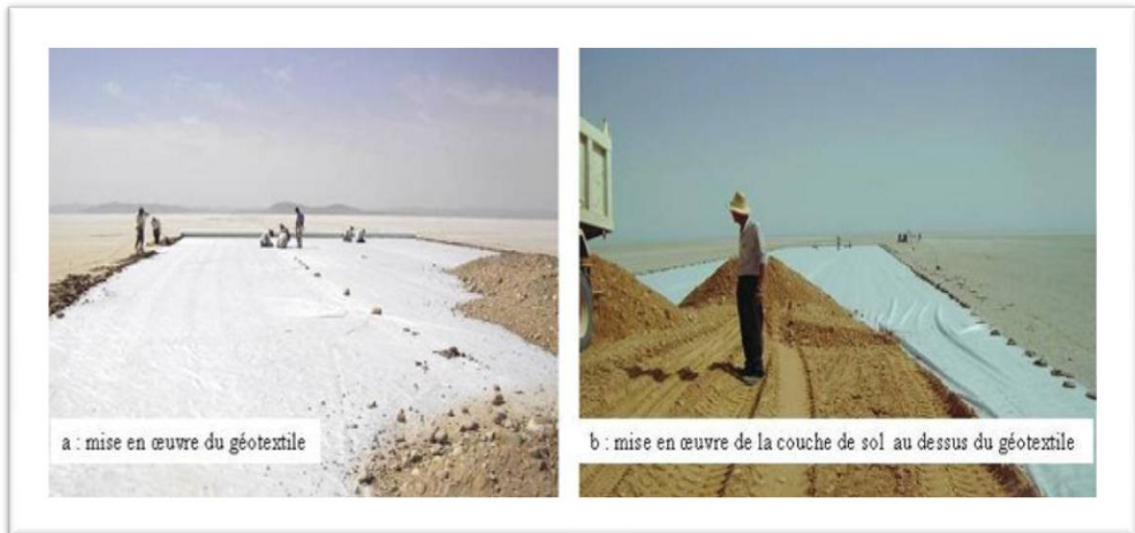
Photo. VIII. 2 : Mise en place du géotextile
