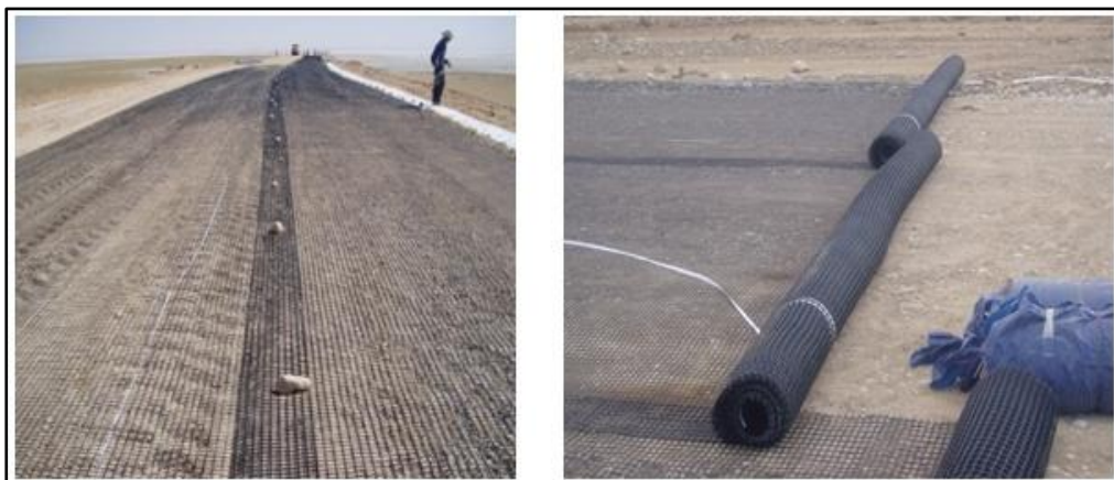
Photo. IX. 4 : Mise en place de géogrille
