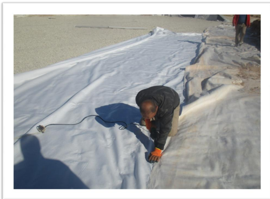
Photo. VIII. 08 : la couverture par le géotextile
