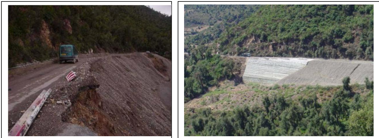
Photo n°6. Mur de soutènement de Tifra
