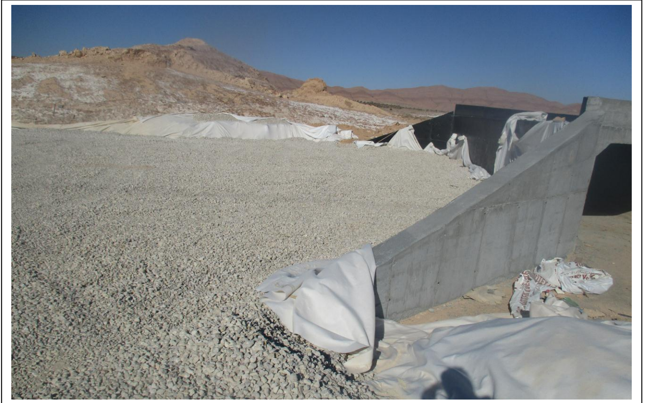
Photo n°14 : pose de la grave concassée sur le géotextile
