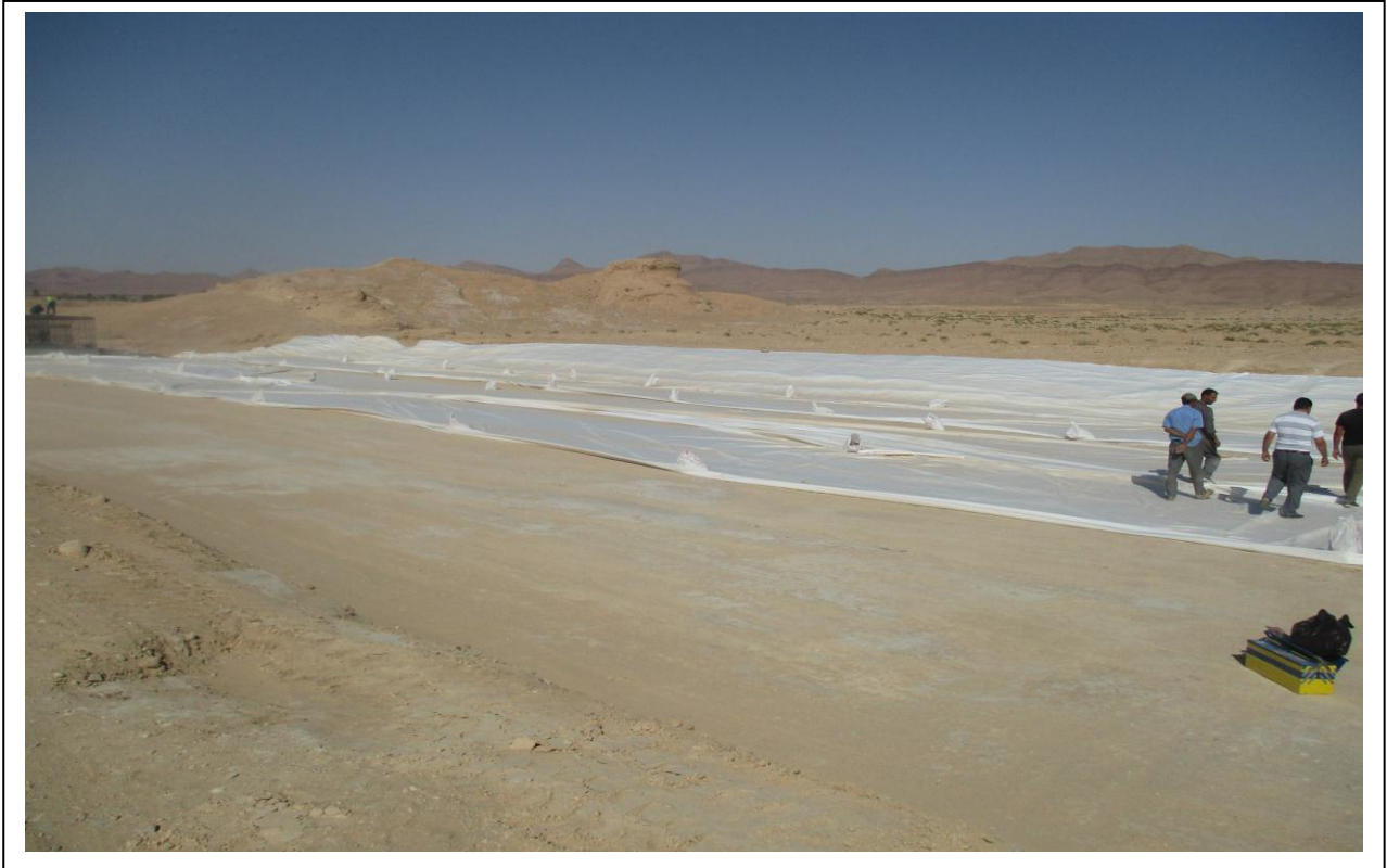
Photo n°12 : pose du géotextile
