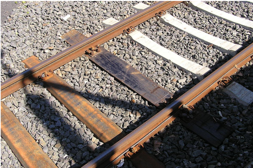
Fig.4. Types de traverses
