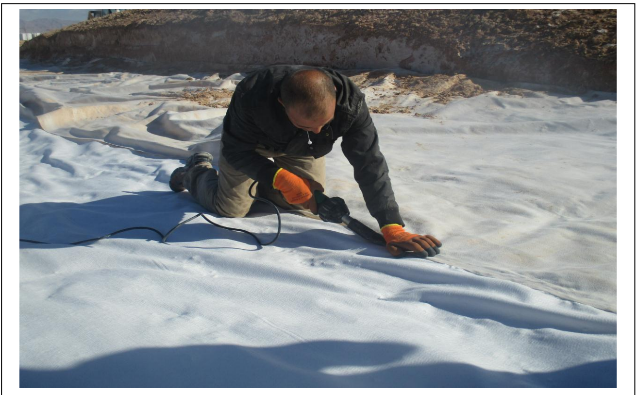
Photo n°15 : liaison des deux rouleaux
