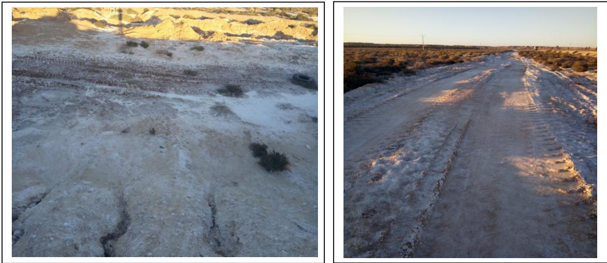
Photo n°8. Exemple d'un sol salé
