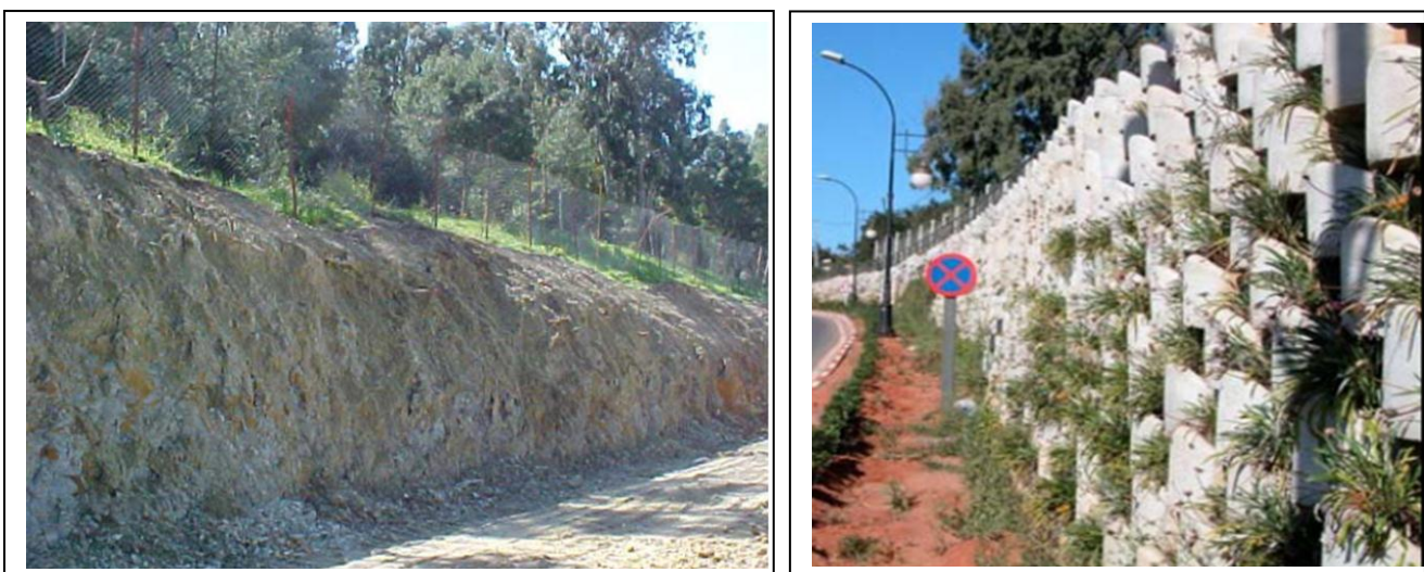
Photo n°7. Mur de soutènement de de Chevalley
