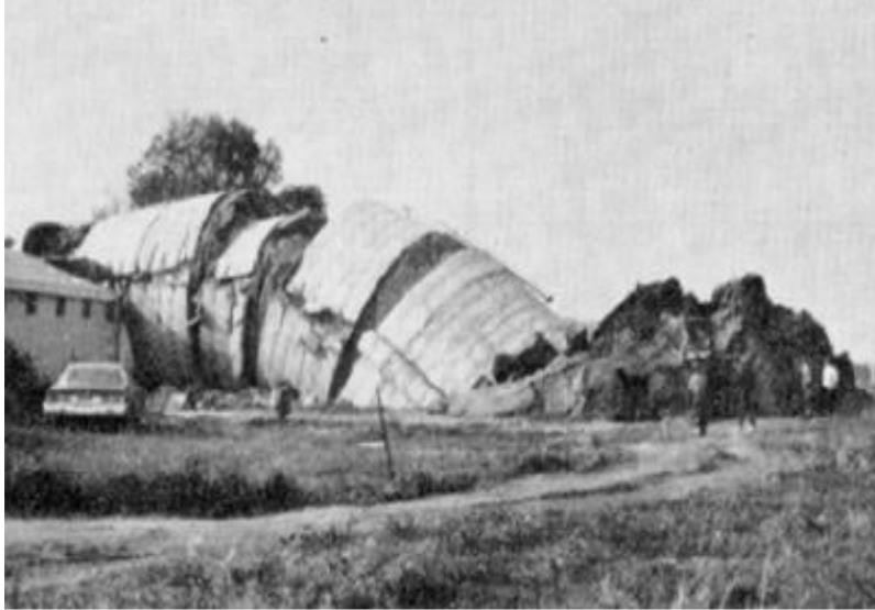
Figure 1.4: Renversement puits effondrement d'un silo.
