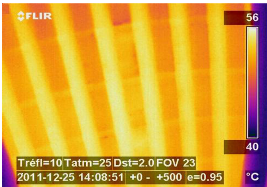
Fig(IV-5) photo de thermomètre infrarouge(Après réparation).
