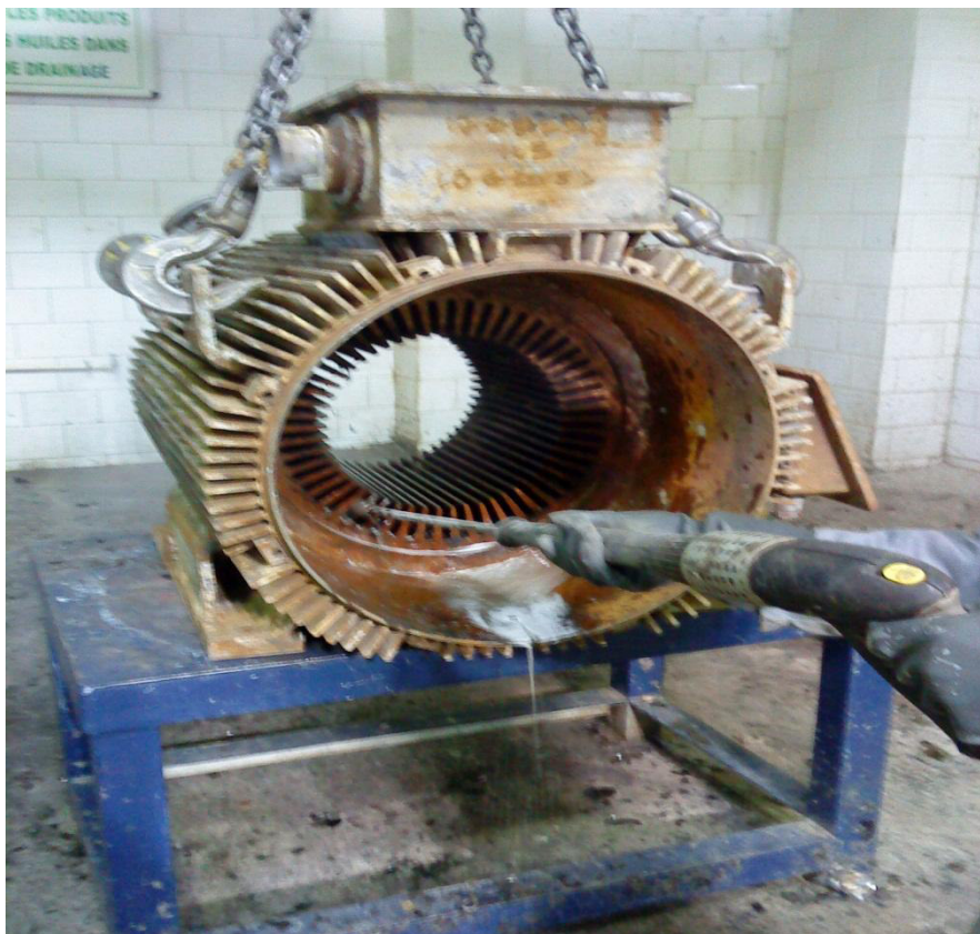
Fig(IV-2) Nettoyage les encoche de stator.
