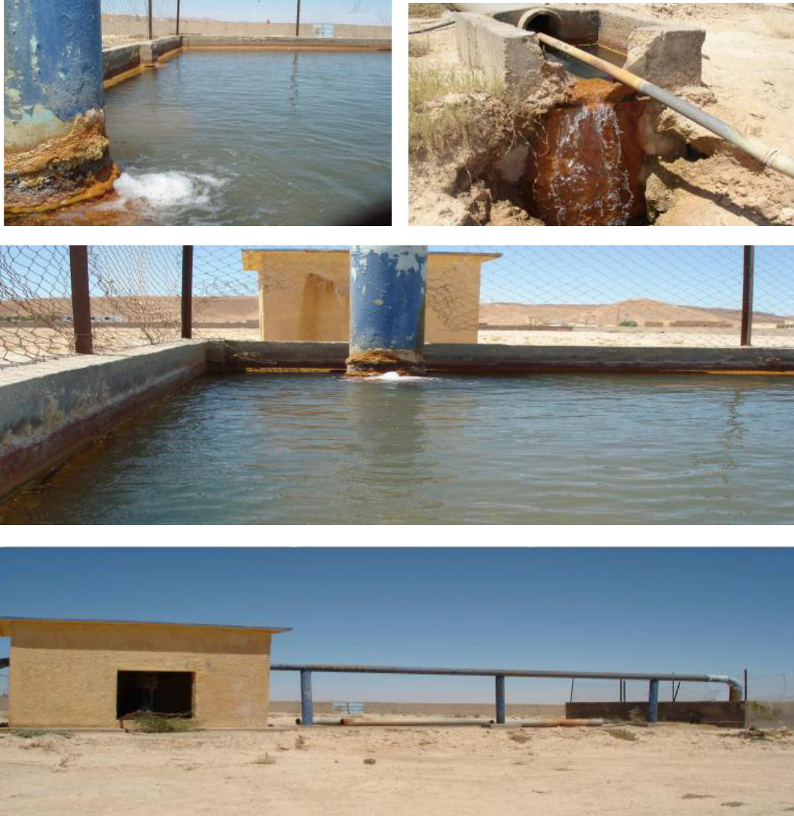
Figure III .28: Photos prises de la source thermique à Bouchegroune.
