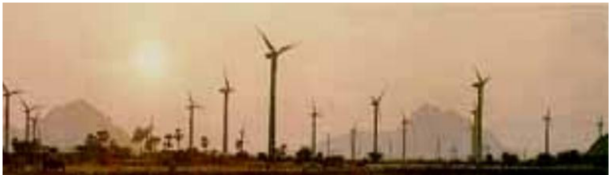
Figure II.13: Ferme éolienne de 10 MW. [23]
