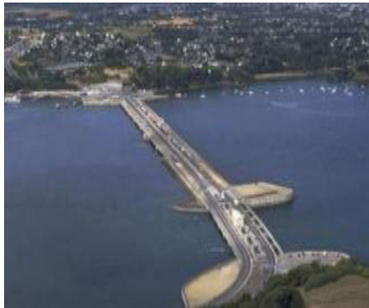
Figure I.15: Usine marémotrice de Rance-France 240MW.[12]
