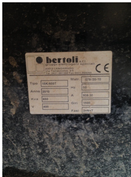
Figure 04-05 :Groupes électrogènes
