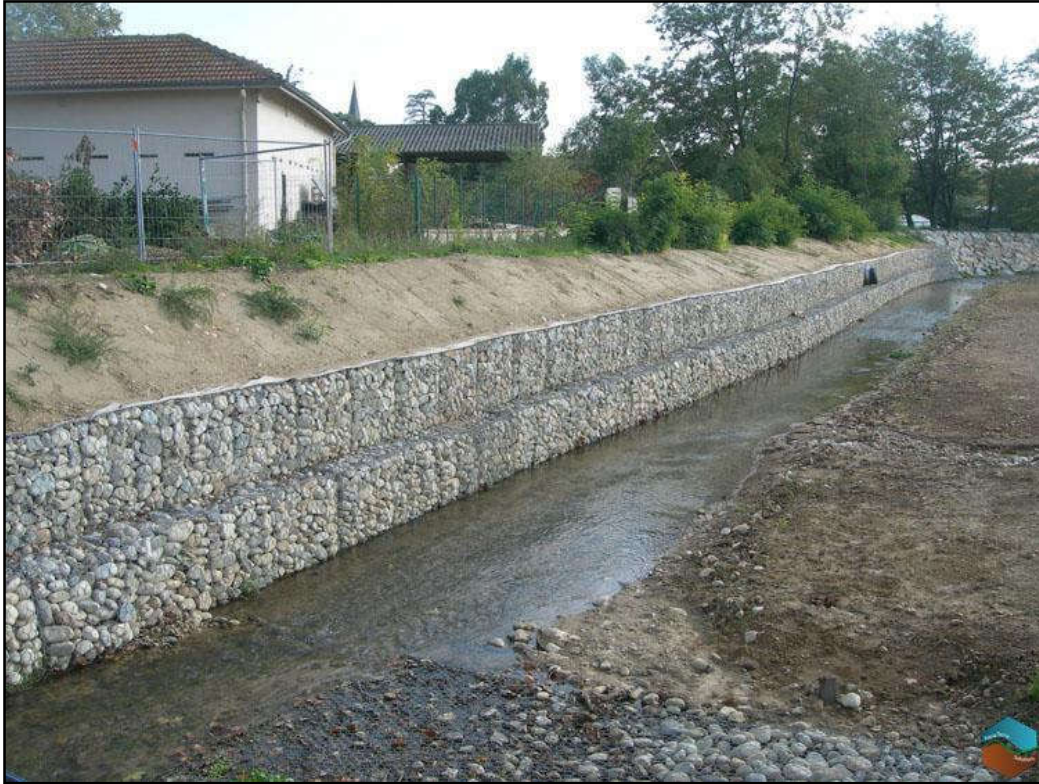
Figure 22 : gabionnage des oueds
