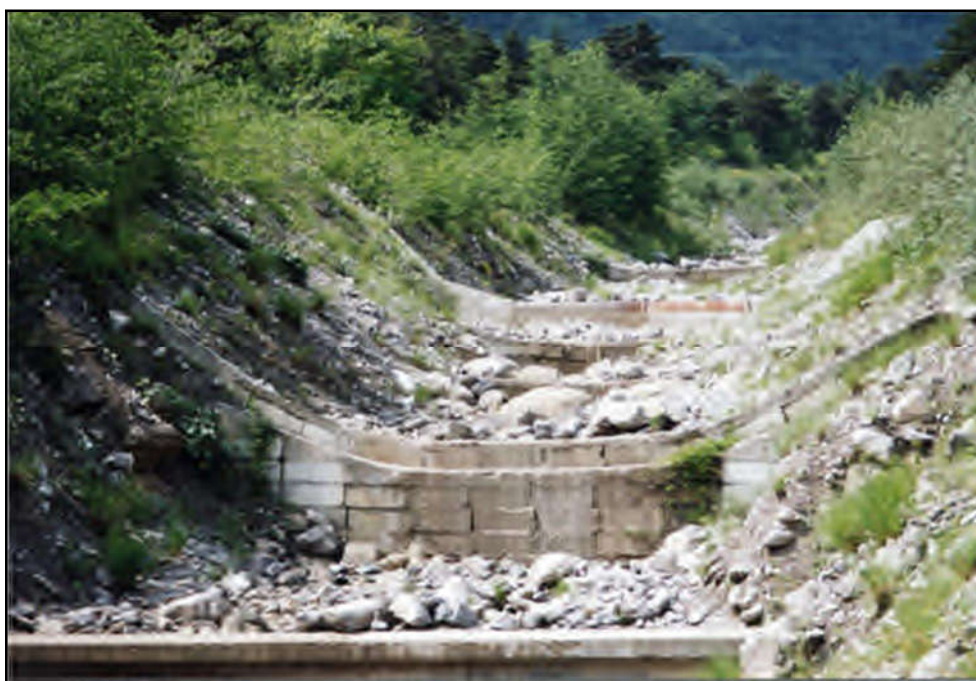
Figure 19 : Succession de seuils dans le chenal d'écoulement
