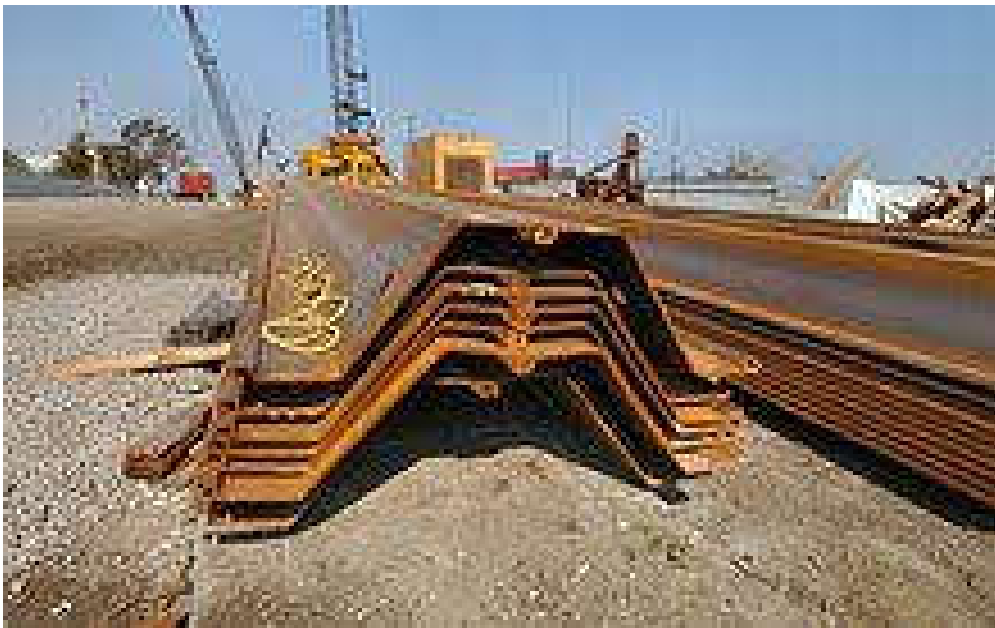
Figure n° 44: Image pour des rideaux de palplanche type HZ/AZ
