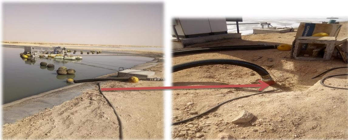
**Figure 14:** Opérations d'extraction et de refoulement des boues vers lits de séchage.
