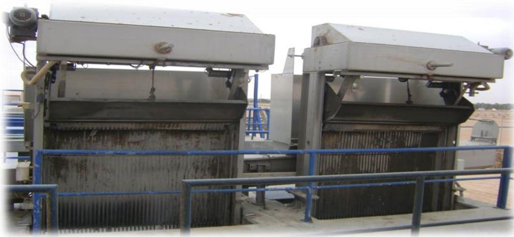
**Figure 8 :** Dégrilleurs automatiques en parallèle
