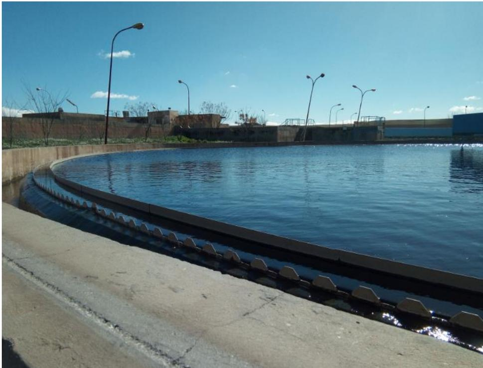
**Figure 11** : Décanteur secondaire
