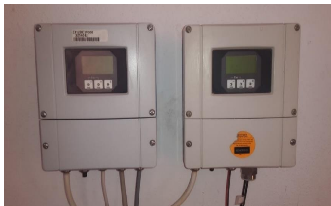
Figure III-7 Enregistreur du débitmètre ultrason (Prosonic Flow 3W)
