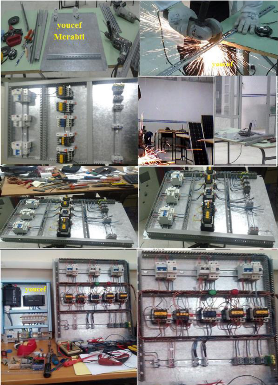
Fig. 3-8 Etapes de réalisation de l'armoire de commutation
