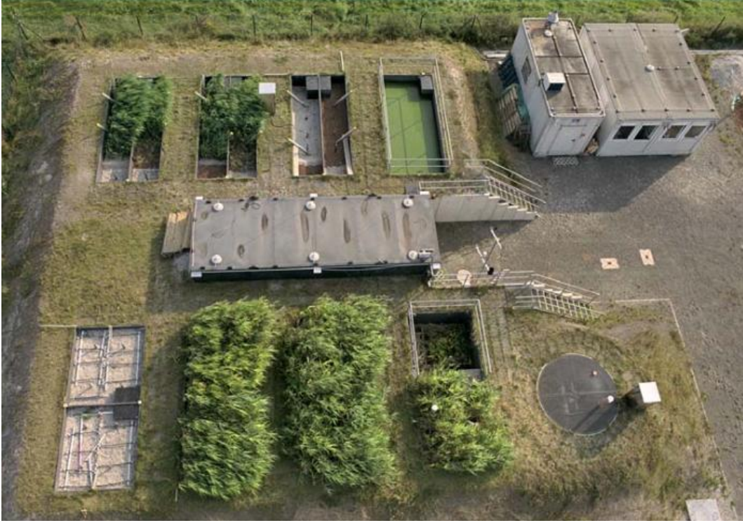
الشكل (1.II) : يبين إحدى محطات المعالجة بالنباتات الطافية بألمانيا (Centre for Environmental Research Leipzig-Halle)
