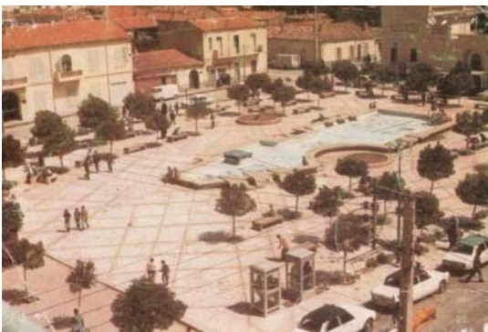
Figure 55 : La placette de l'église, aujourd'hui placette Harsous avec nouveau traitement de sol, bancs, cabines téléphoniques et bassin d'eau. Source : Carte postale
