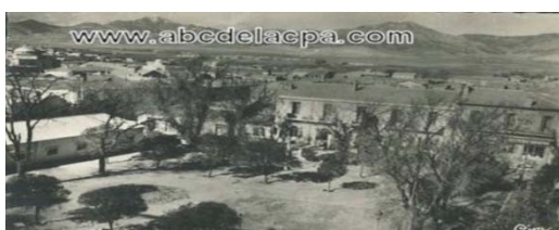
Figure 64 : . La place du théâtre aménagée en square, avant la réalisation même du théâtre Source: abcdelaepa.com
