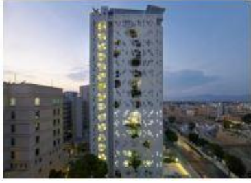
الصورة رقم ( 1 - 11) برج في نيقوسيا القبرصية لمعماري الفرنسي Jean Nouvel المصدر : موقع archi-news . 2015
