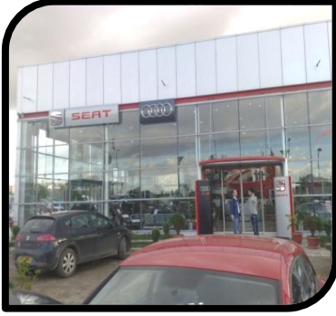
الصورة رقم ( III - 63 ) الواجهة الرئيسية
