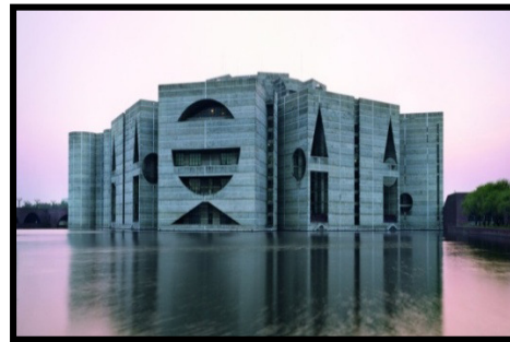
Figure 12 : Bâtiment de l'Assemblée Nationale de Bangladesh. Source : wikipédia
