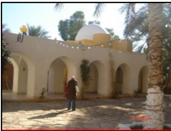
Figure 70 : L'hôtel est fait :-de murs renforcés.- de béton armé (poteau/poutre) .- utilise des matériaux locaux pour la région,- à savoir le plafond en bois.
