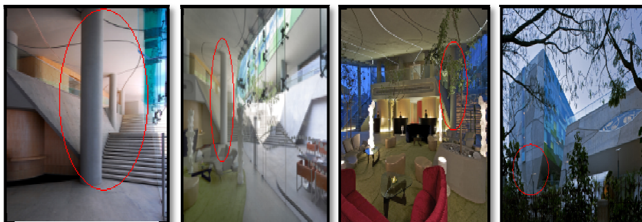
Figure 36: L'hôtel est fait : -de béton armé (poteau/poutre) . -mur porteur.
