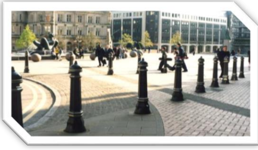
الصورة 33: تمثل حاجز فاصل للمشاة المصدر: http://www.cabe.org.uk
