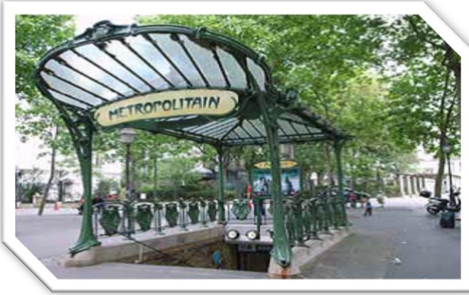
الصورة 48: تمثل مدخل مترو
