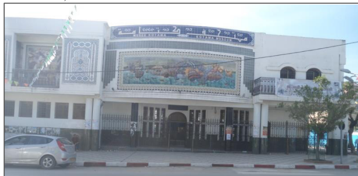
Figure 136: La façade principale de l'extension. (Source: auteur)
