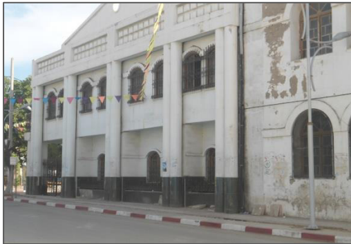
Figure 134: Façade de l'extension à côté de l'ancienne bâtisse. (Source: auteur)
