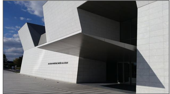
Figure 119: Entrée du projet sous l'ombre de l'auvent. (Source : https://fr.wikipedia.org/wiki/Mus%C3%A9e_Aga_Khan )
