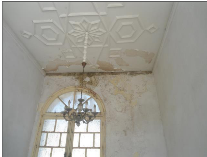
Figure 144: Dégradation de la peinture à cause d'une mauvaise aération des espaces. (Source: auteur)
