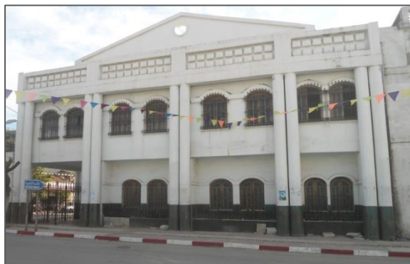
Figure 142: Façade sud-ouest. (Source: auteur)
