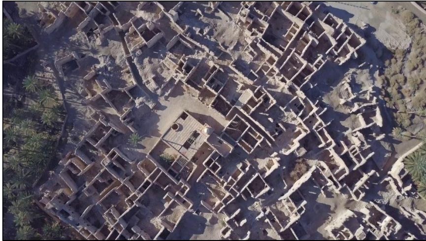
Figure 10 : Vue de ciel sur le vieu Ksar de Lichana, Biskra.
