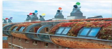
Figure 7: représente les trompettes à double flux et les toits végétalisés de Bed Zed.
