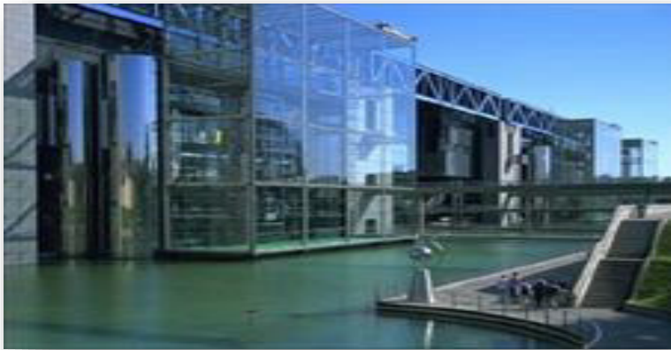
Figure 38n67 : double façade sud est entièrement vitrée
