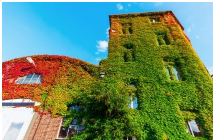
Figure I 11 : Traitement façade ouest,
