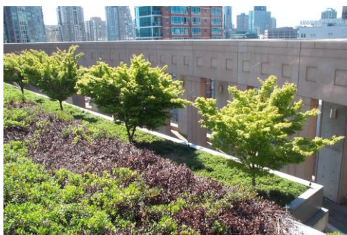
Figure I 13 : toit vert intensif : Bibliothèque publique de Vancouver,
