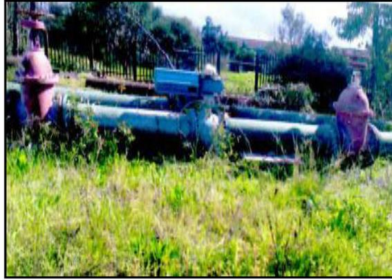
**Figure 6 :** Conduite d'arrivée d'eau
