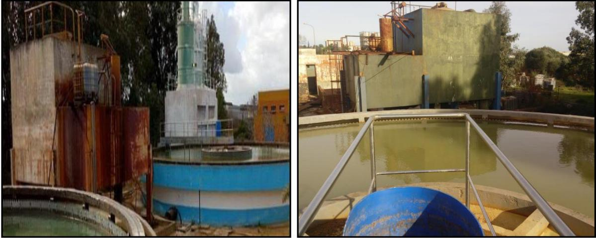
**Figure 9:** Brise charge et décanteur
