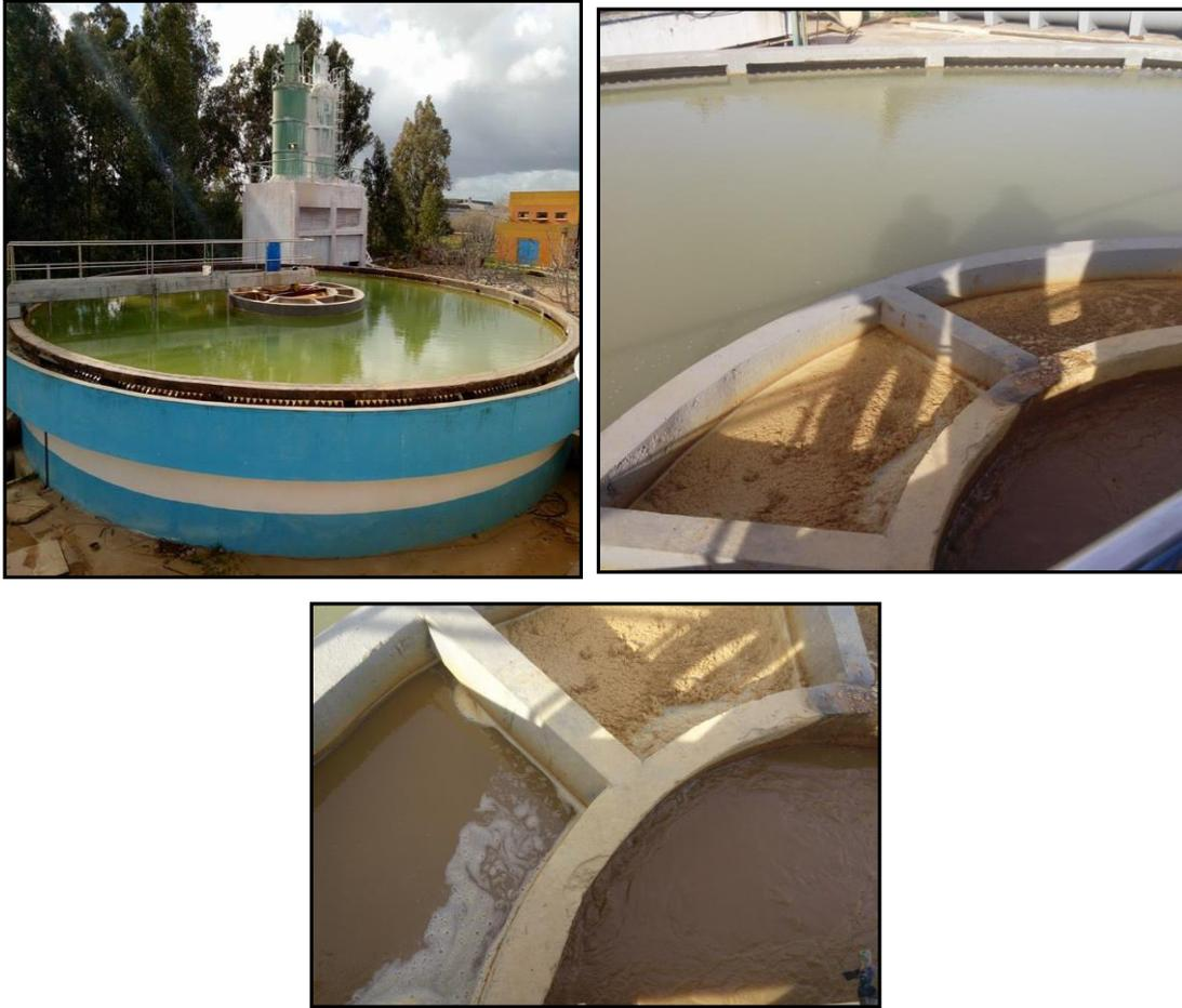
**Figure 11** : Le bassin de coagulation floculation et de décantation
