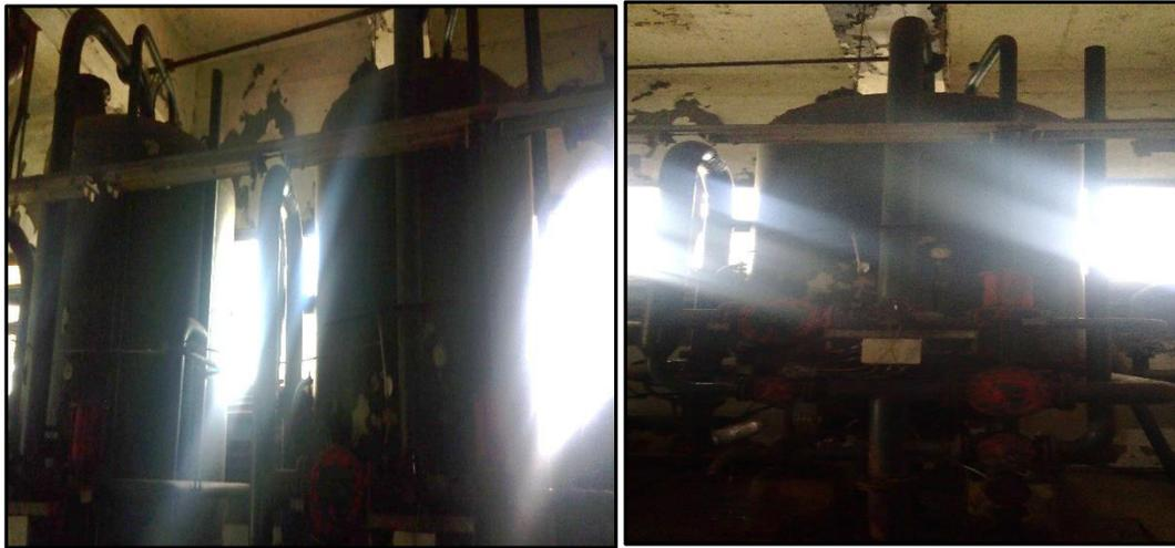
**Figure 17 :** Installation de l'adoucissement par résines
