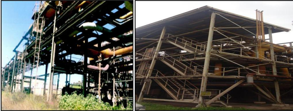
**Figure 4:** Racks conduites (vapeur – gaz – eau – air).
