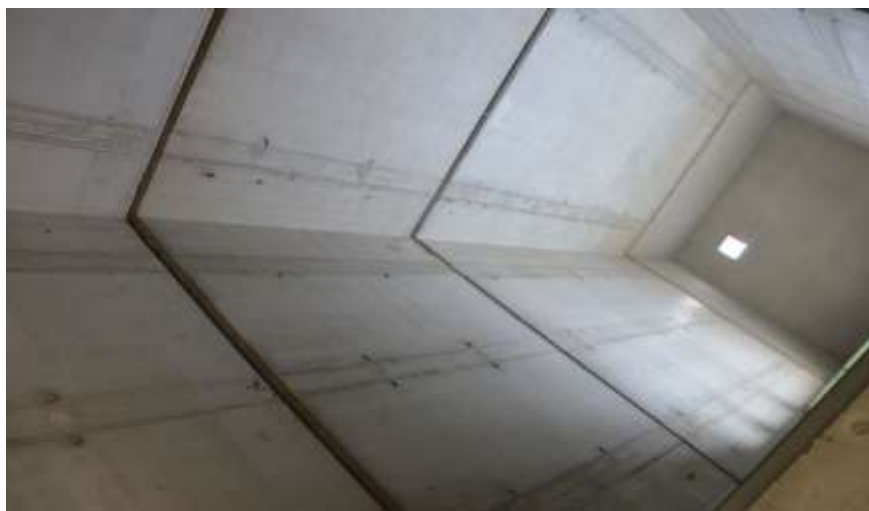
Fig. IV.22 un ascenseur préfabriqué
