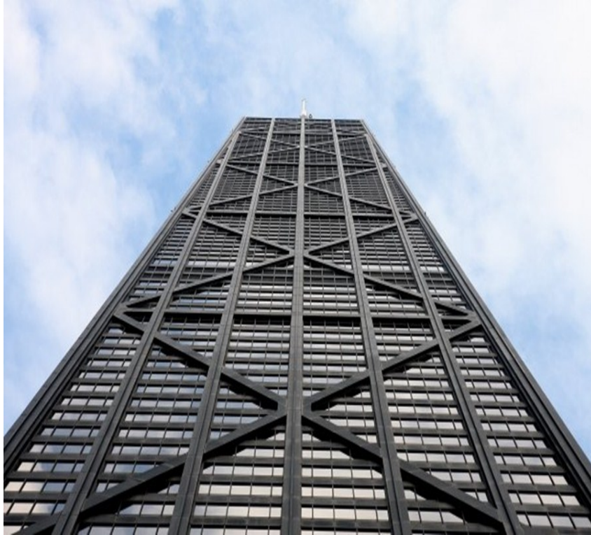
Figure (I .1) : système de contreventement
