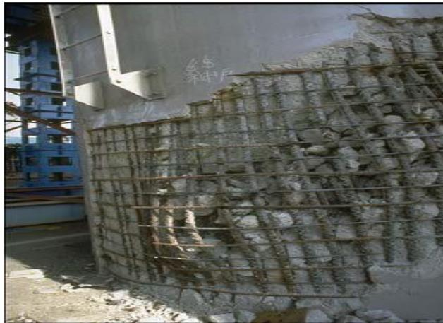
(figure1.10) : Rupture « ductile » d'un poteau de béton armé [10].
