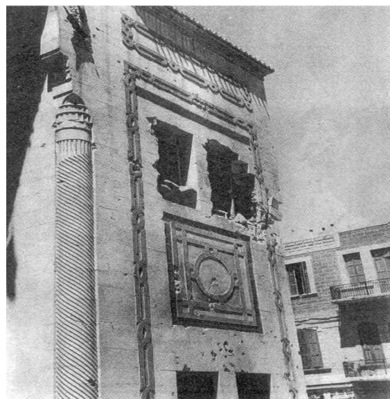
الواجهة الرئيسية لمبنى المجلس النيابي أثر اعتداء المستعمر الفرنسي
