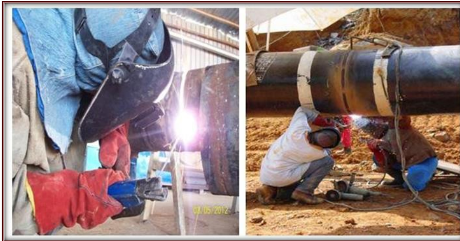
Figure I.5 : Soudage manuel des pipelines [23].
