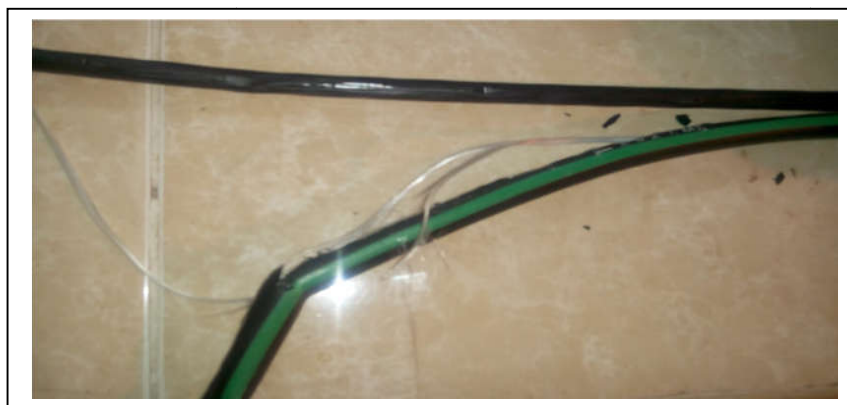
Figure IV. 3 : Séparez la gaine extérieure de revêtement.
