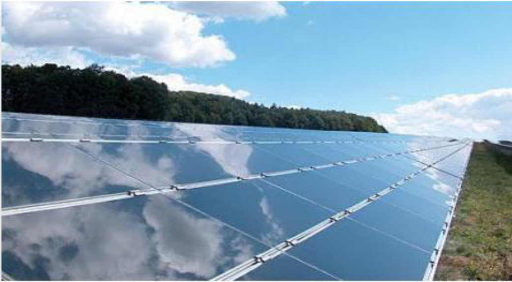
Figure (I.11): modules verre-verre au Telluride de Cadmium, efficacité de 9 à 11%.
