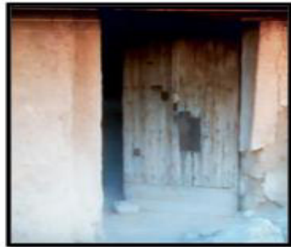
الصورة رقم (05): المدخل
