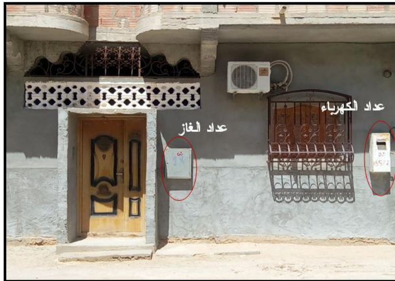
الصورة رقم (34): الربط بالكهرباء والغاز
