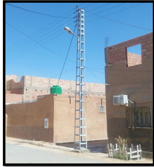
الصورة رقم (32): عمود كهرباء
