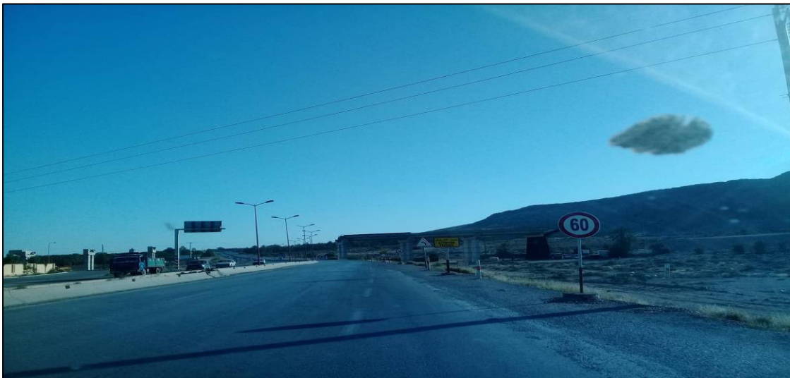
الشكل 10: صورة طريق بوسعادة (المصدر: التقاط الطالبة 2019)
