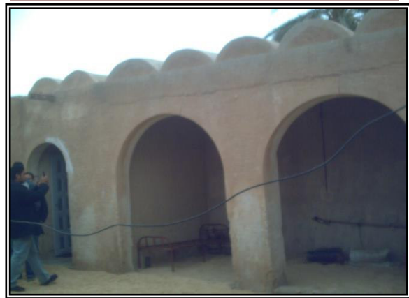
الصورة رقم(35): توضح الصباط الغربي
