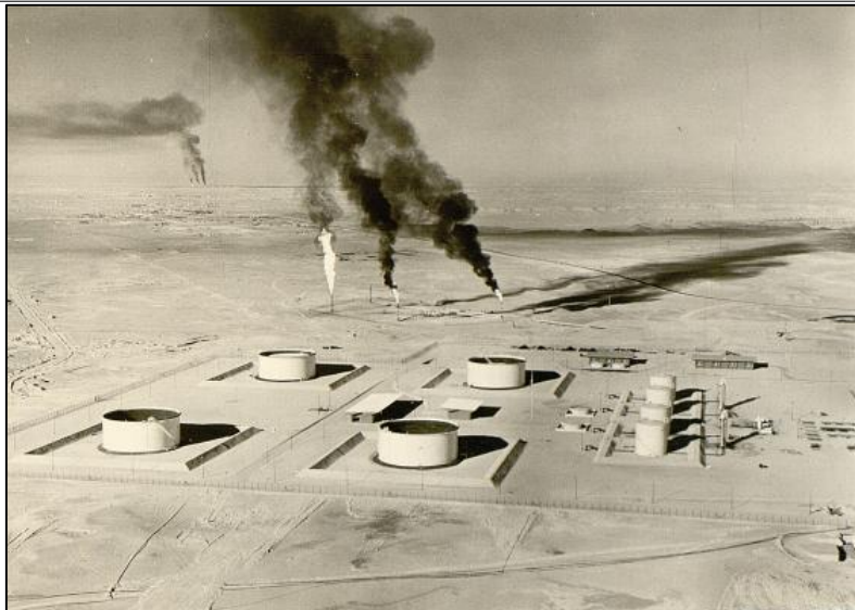
Photo 13 : centre de production de la SN REPAL 1956 Hassi-Messaoud
