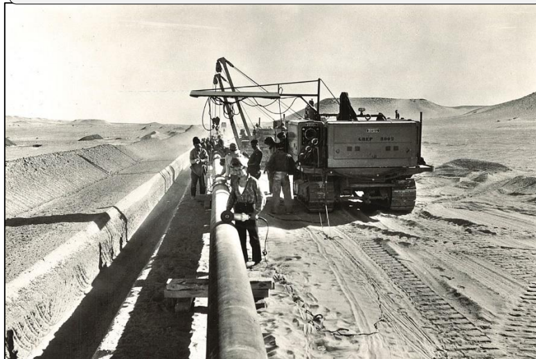
Photo 14 : Les travaux de pose de PIPELINE
