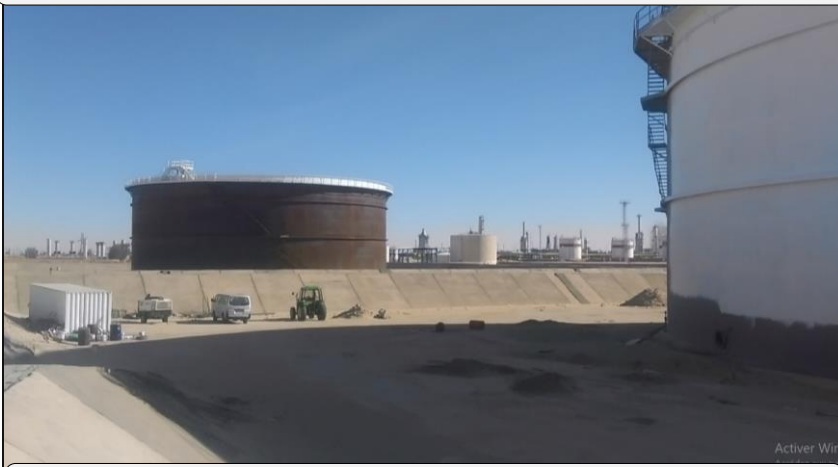
Photo 16 : stockage de carburant Sonatrach, Hassi-Messaoud.
