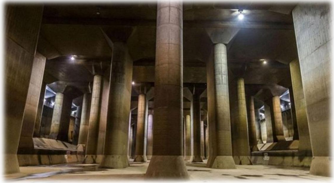
منشآت وأنفاق لتصريف مياه الفيضانات بمدينة طوكيو -اليابان
